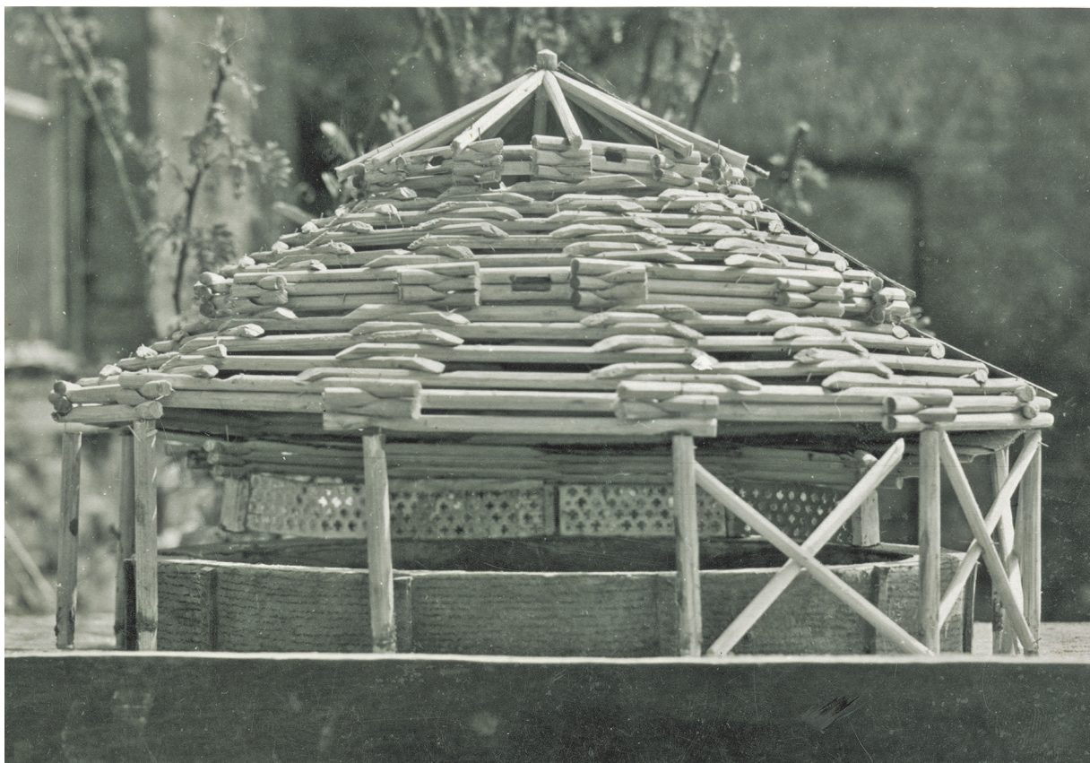
Ил. 57. Макет бревенчатой конструкции трехъярусного шатра над законсервированными руинами Смоленской ротонды
