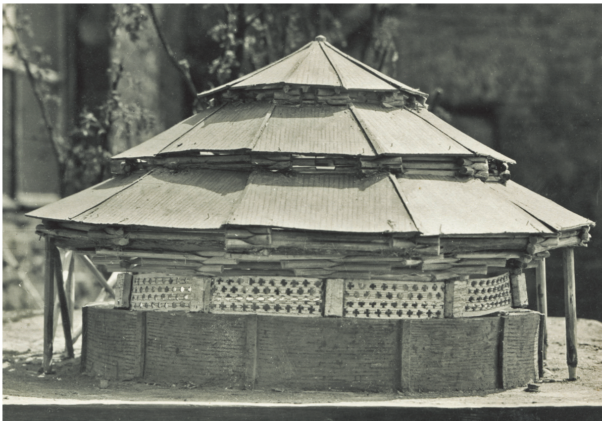
Ил. 59. Макет деревянного шатра со ступенчатой трехъярусной дощатой кровлей над законсервированными руинами Смоленской ротонды
