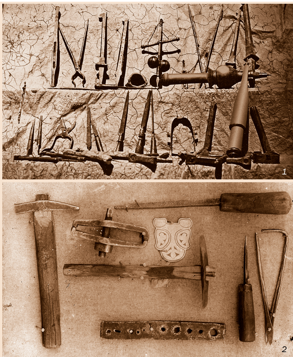
Рис. 47. Инструменты мастеров-металлистов. 1 — рабочие инструменты медника ( асбоби мехгячари ) (клещи, молоток, наковальни, ножницы, коловорот и др.). Оседлое население Западного Туркестана. Самарканд. Вторая половина XIX в. Собиратель К.П. Кауфман; 2 — инструменты серебряных дел мастера. Казахи. Казахстан. 1899 г. Автор С.М. Дудин. 1, 2 — Музей антропологии и этнографии им. Петра Великого (И 1718–191; № 1199–290).
