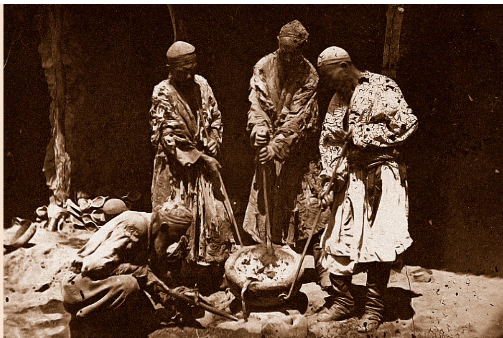
Рис. 51. Разливка чугуна из тигля в формы. Оседлое население Западного Туркестана. Самарканд. Вторая половина XIX в. Собиратель К.П. Кауфман. Музей антропологии и этнографии им. Петра Великого (ИИ 1718–191).
