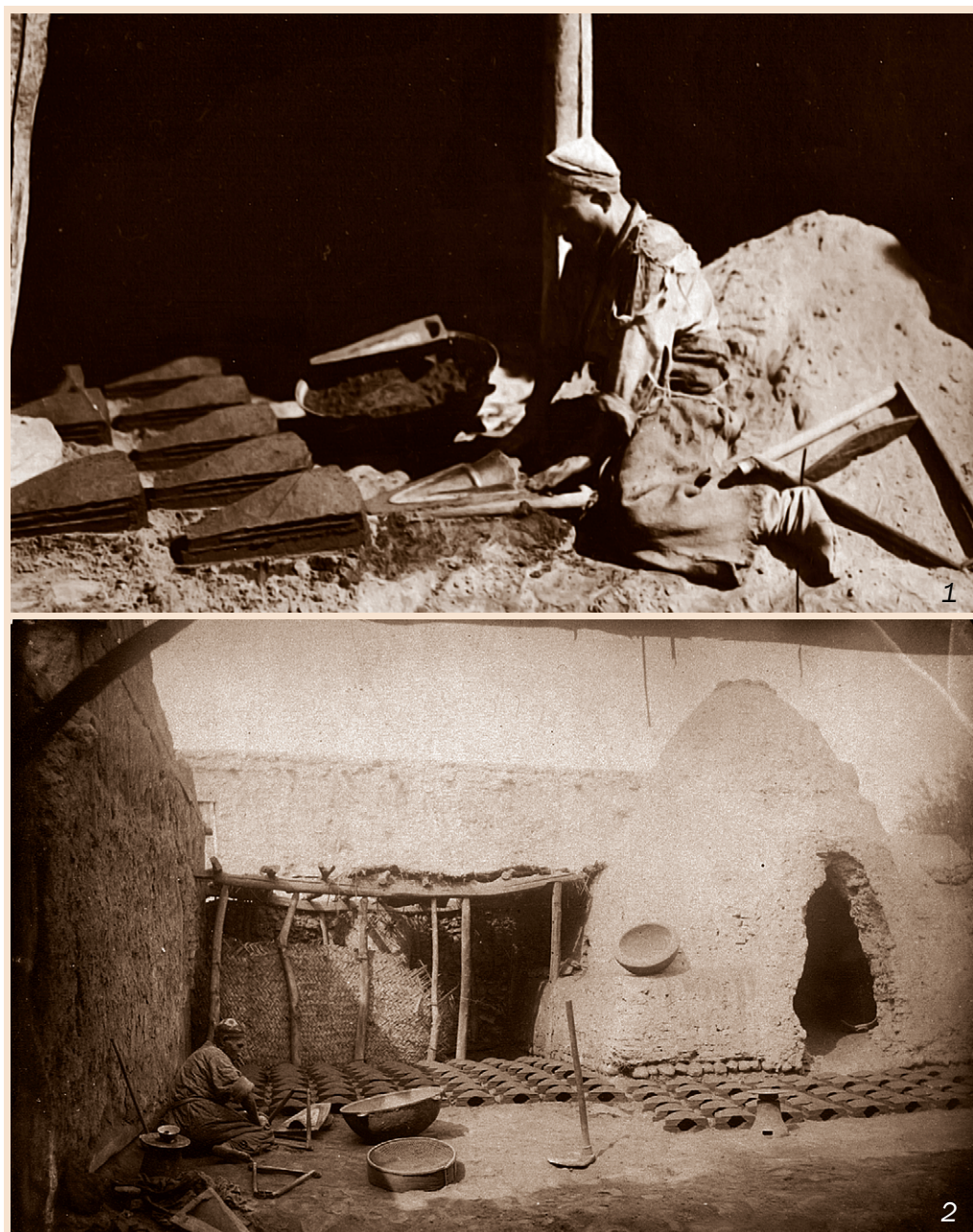
Рис. 44. Литье чугуна у оседлых народов Средней Азии. 1 — чугунолитейное производство: заготовка форм. Узбеки. Узбекистан. Начало XX в.; 2 — чугунолитейный завод. Сарты. Самарканд. Конец XIX в. Автор Ф.Г. Ордэн. Музей антропологии и этнографии им. Петра Великого (1 — И 1438-1; 2 — № 255-274).
