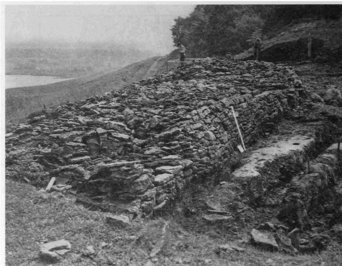
Рис. 162. Остатки юго-восточного участка крепостной стены (участки 45–46). Вид с северо-запада. Фото П.Г. Гайдукова, 1980 г.
