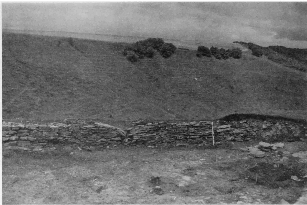
Рис. 151. Остатки крепостной стены на участке 21. Вид с востока. Фото В.В. Седова, 1974 г.
