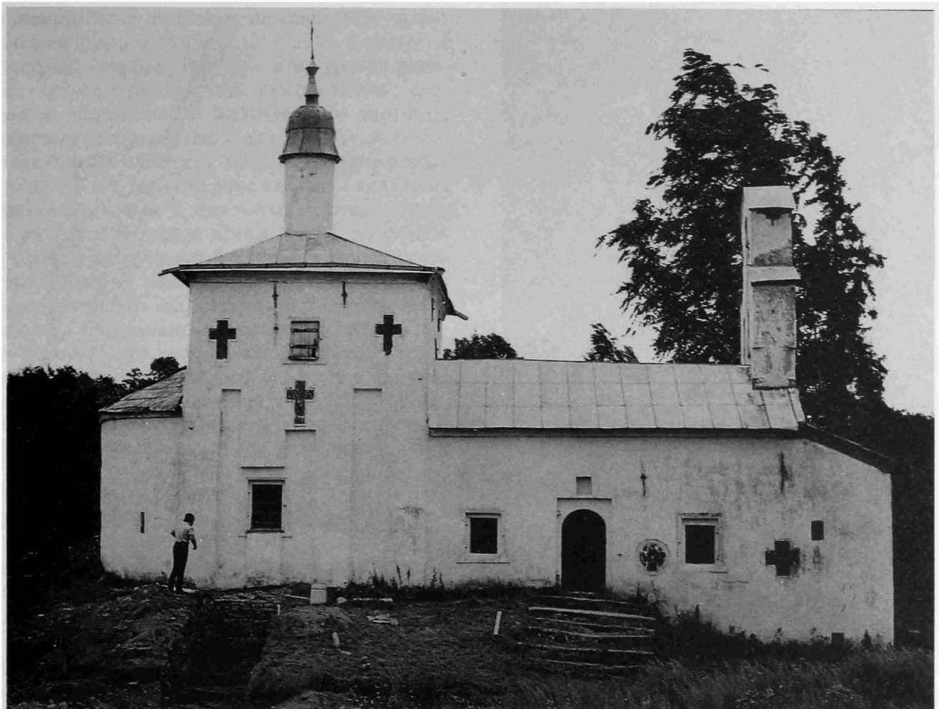
Рис. 217. Вид Никольской церкви и местоположение северной траншеи. Вид с севера. Фото П.Г. Гайдукова, 1983 г.
