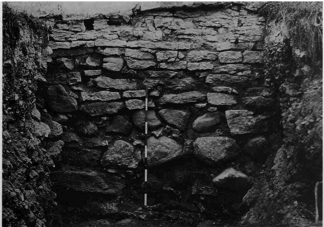
Рис. 218. Фундамент и нижняя часть кладки стены Никольской церкви, открытые в северной траншее. Вид с севера. Фото П.Г. Гайдукова, 1983 г.
