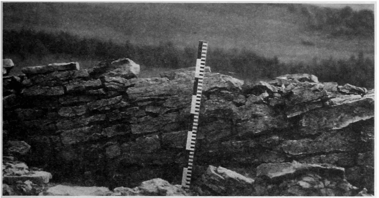
Рис. 172. Кладка восточной стены подполья башни. Фото В.В. Седова, 1975 г.
