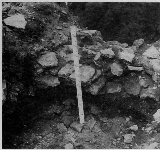
Рис. 206. Внутренняя облицовка плитняковой стены на вершине вала (траншея 3, 1985 г.). Вид с севера. Фото А.Р. Артемьева, 1985 г.
