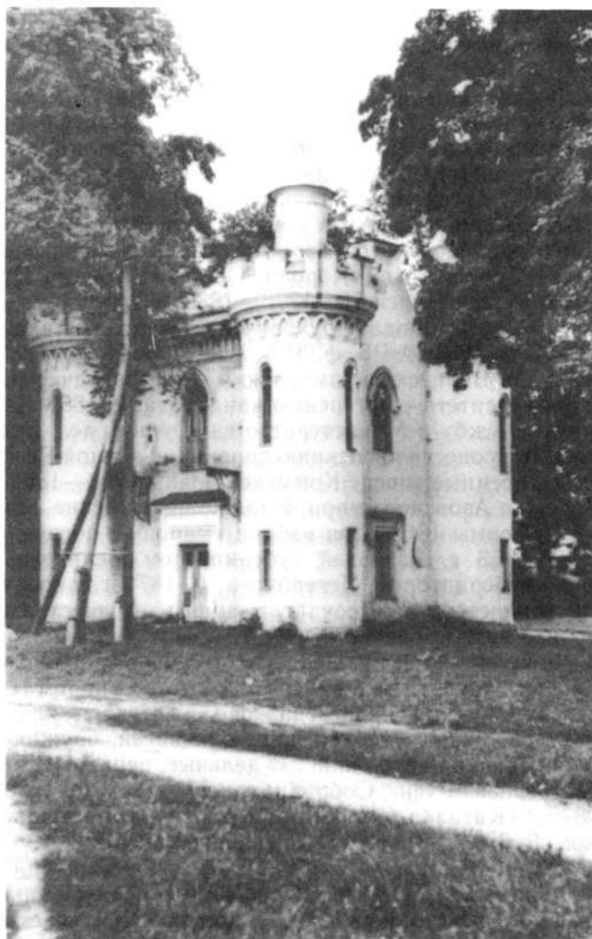
Павильон-«скарбница» в Станькове. Постройка 1892 г. Фото Л. В. Алексеева. 1977 г.
